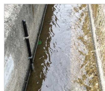
アタッチメント水路計測
