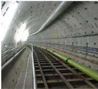
図23.雨水貯留管の例
